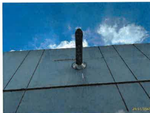
ท่อระบายอากาศเครื่องกำเนิดไฟฟ้าสำรอง
