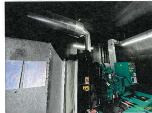
ท่อระบายอากาศเครื่องกำเนิดไฟฟ้าสำรอง
