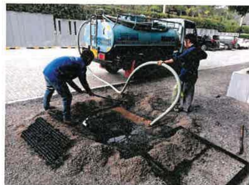
สูบล้างระบบน้ำเสียไปจำกัด
