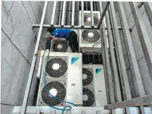
ล้างทำความสะอาดเครื่องปรับอากาศในพื้นที่ส่วนกลาง
