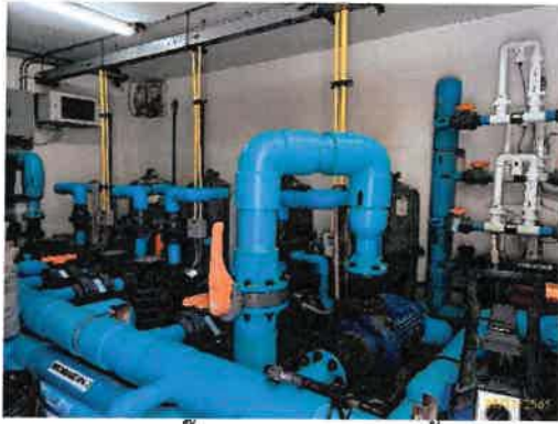
ระบบปั๊มและกรองสวะย่น้ำ
