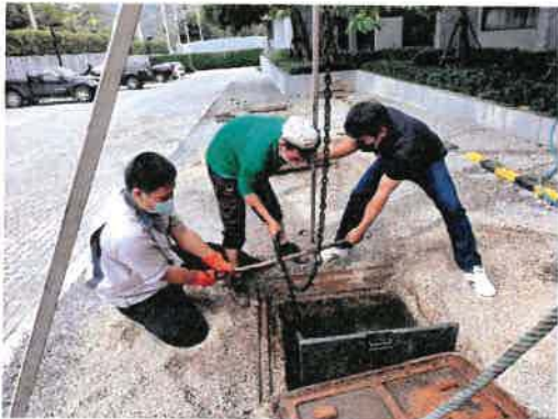
สูบล้างระบบน้ำเสียไปจำกัด
